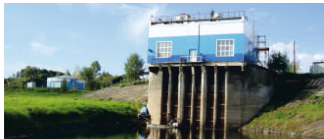
НФС-2. Насосно-фильтровальная станция №2
