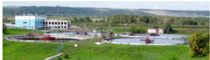
Очистные сооружения канализации
