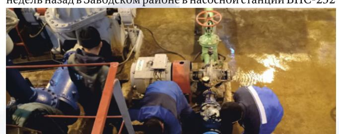
бригада ЭМУАВР, во время промывки РЧВ, производила замену неисправной запорной арматуры диаметром 150 мм, которая уже не держала давление, пропускала воду. А перед этим КНС-503, которая находится в районе Байдаевского
