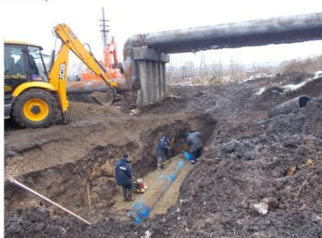
Самотечный железобетонный коллектор канализации диаметром 600 мм в Кузнецком районе, заменено 680 метров по причине разрушения труб и зарастания смолинистыми отложениями.
